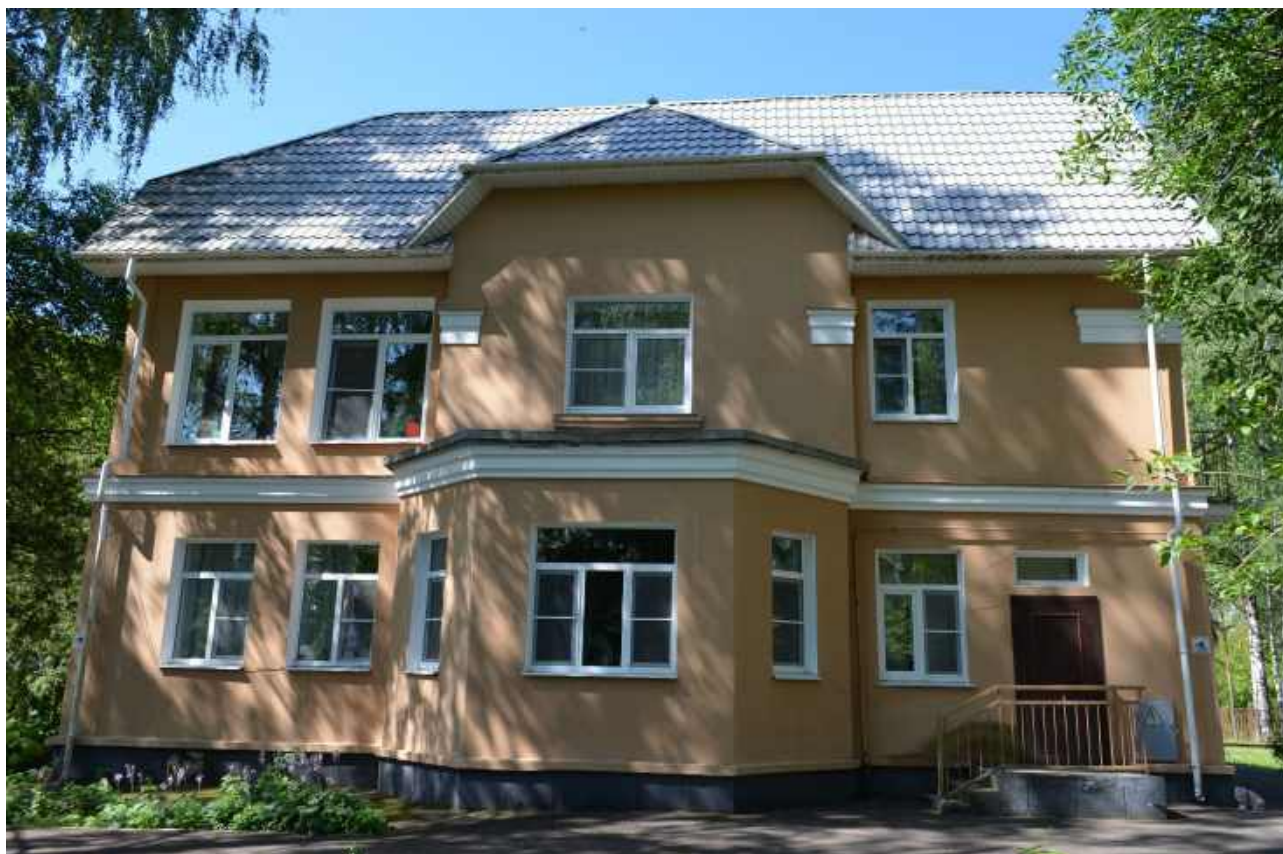
Точка фотофиксации №11. Общий вид. Восточный фасад
