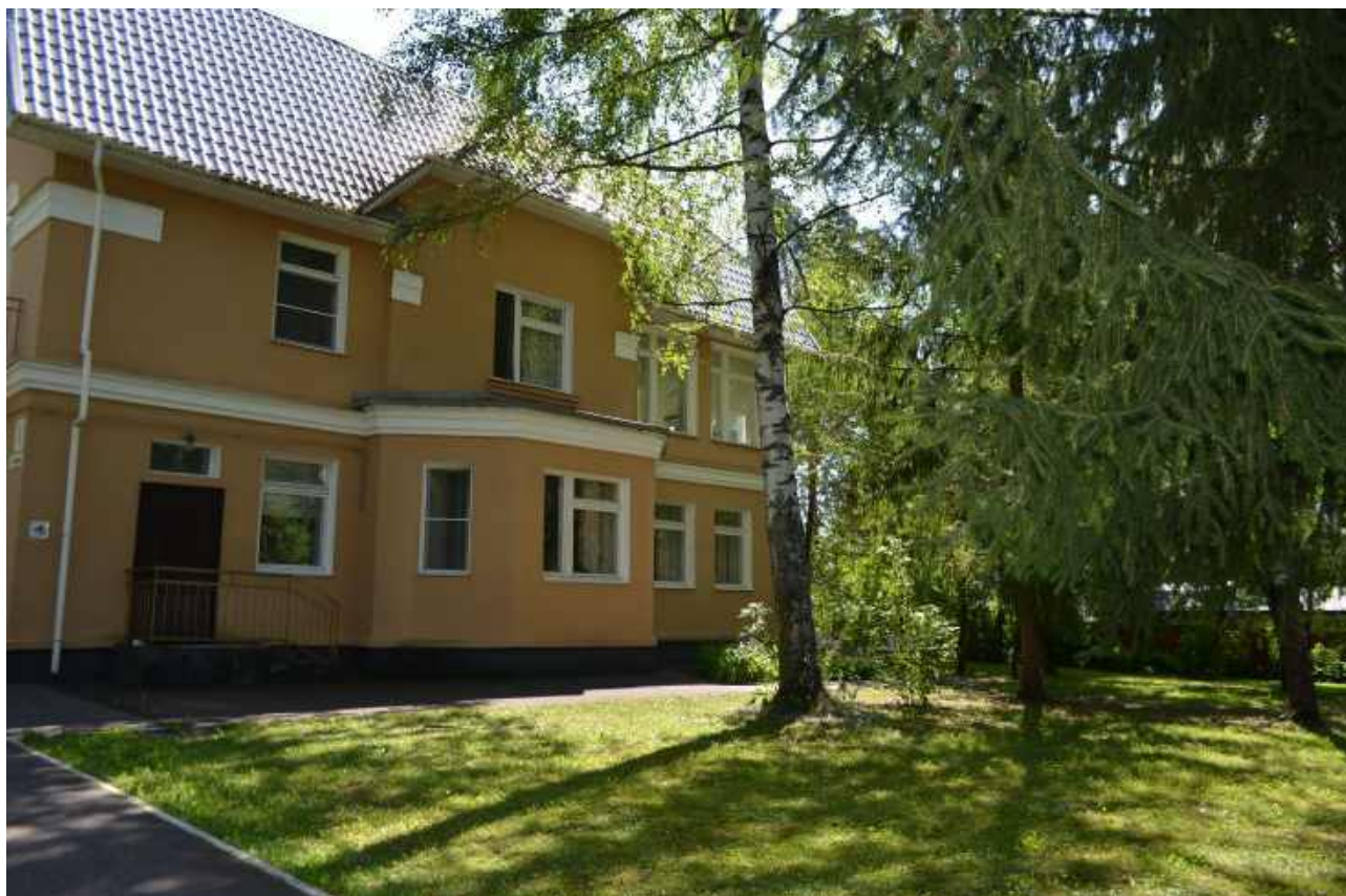
Точка фотофиксации №6. Общий вид. Западный (боковой) фасад
