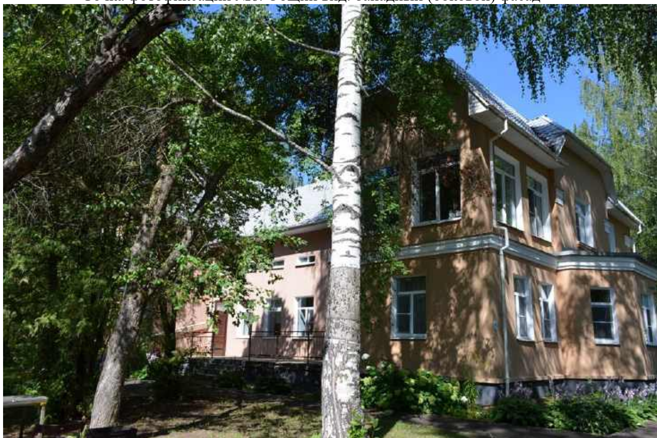
Точка фотофиксации №7. Общий вид. Южный и восточный фасады
