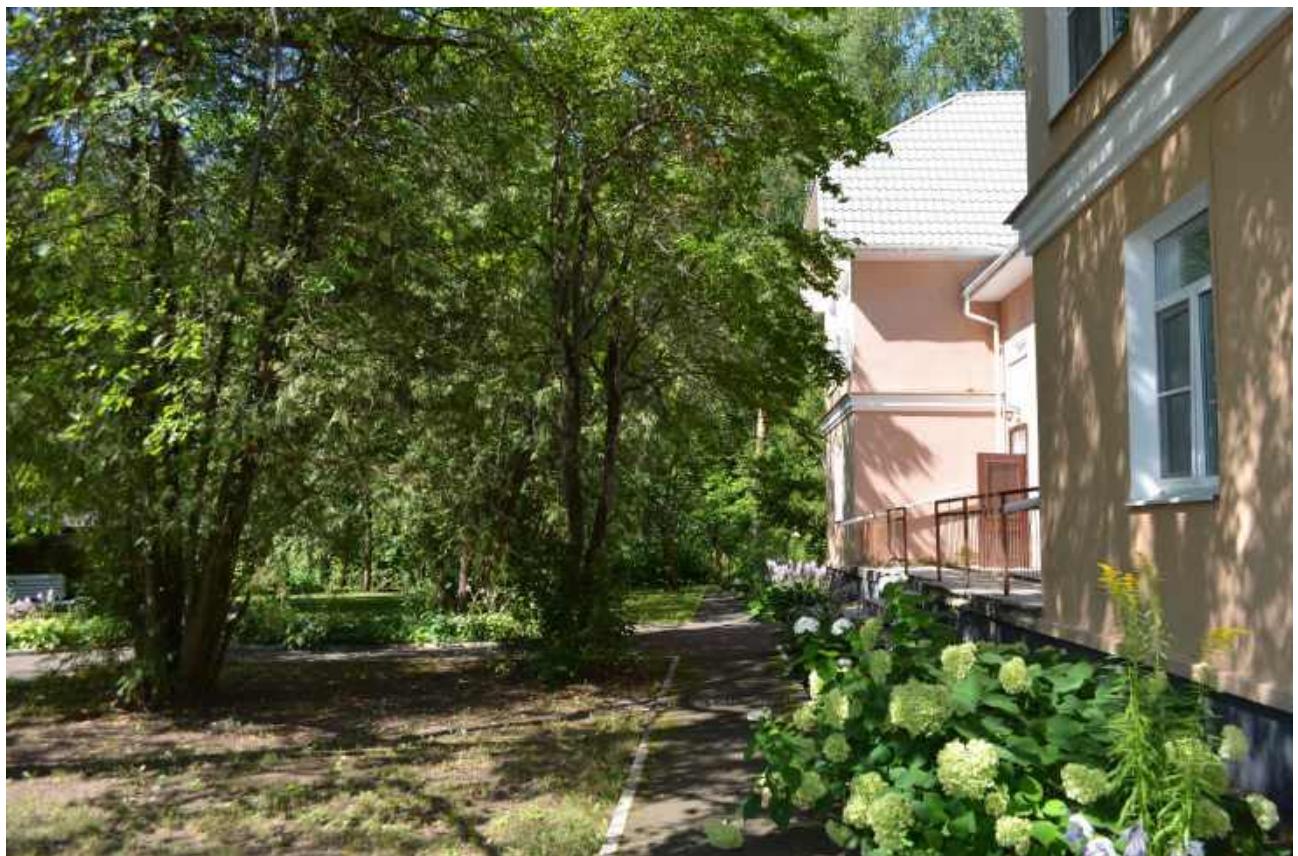
Точка фотофиксации №10. Общий вид. Южный фасад
