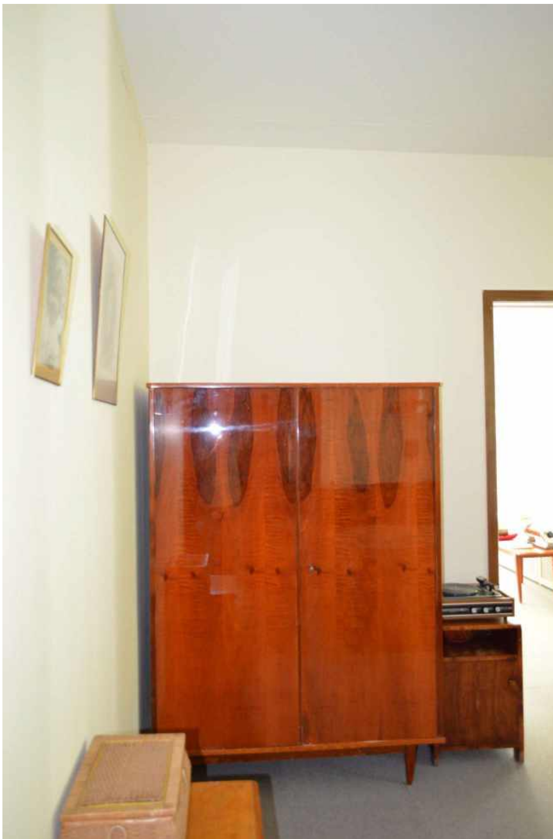
Точка фотофиксации №56. Квартира №1. 2-ый этаж. Внутренние помещения.
