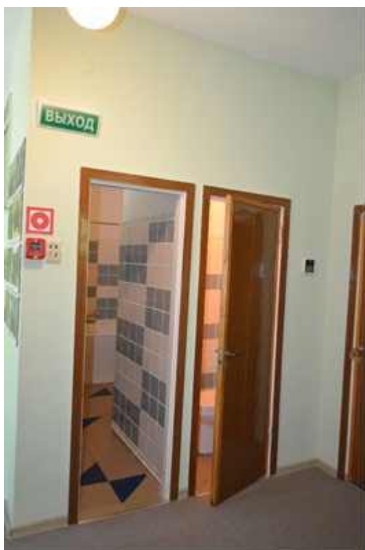
Точка фотофиксации №48. Квартира №1. 2-ый этаж. Внутренние помещения.
