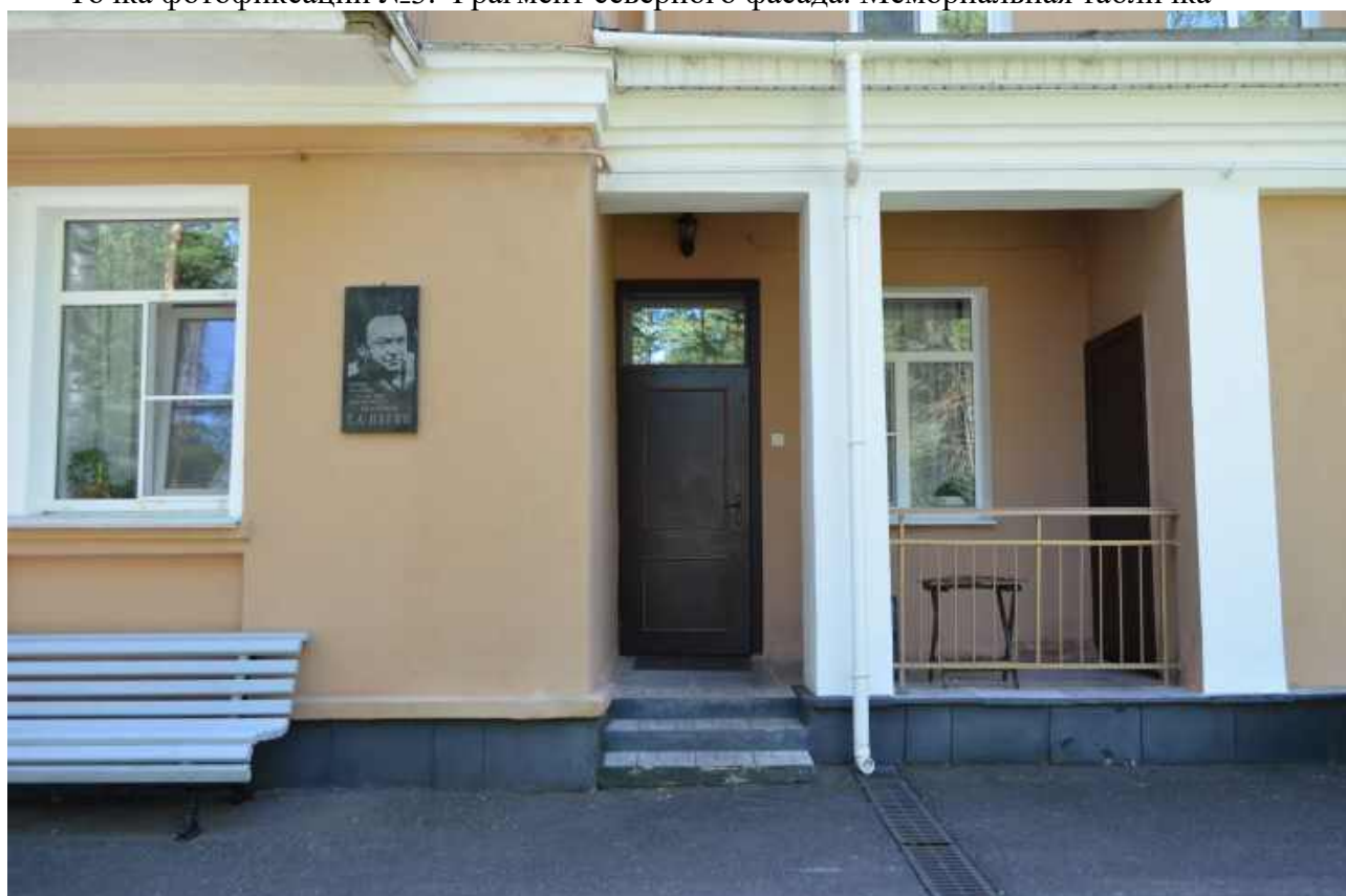
Точка фотофиксации №4. Фрагмент северного фасада. Вход в кв. №2
